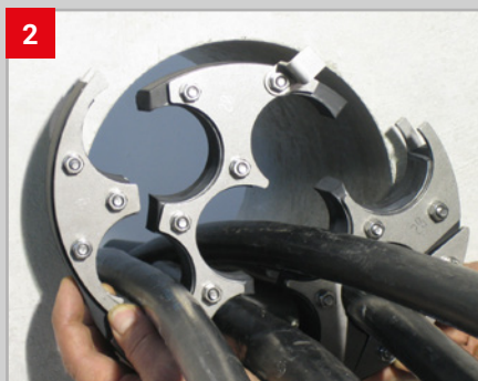
2 Zwiebelschnitteinsätze entfernen und aufgeklappte GPD um Kabel herumlegen
