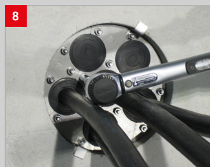
8 Muttern anziehen! Fertig! Wasserdicht bis 2,5 bar!
