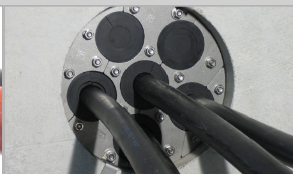
7 Zwiebelschnitteinsätze nach einander einsetzen!
