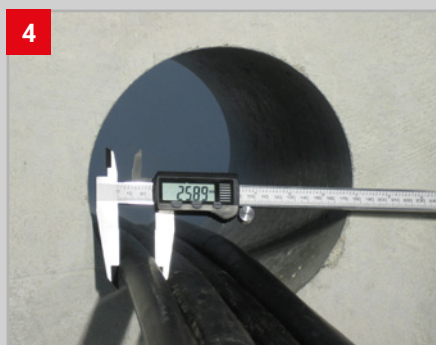
4 Kabeldurchmesser messen!
